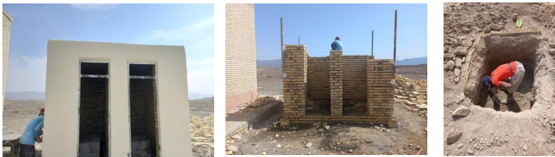
تصاویر شماره سه: ساخت سرویس بهداشتی دبیرستان دختران اردیبهشت
