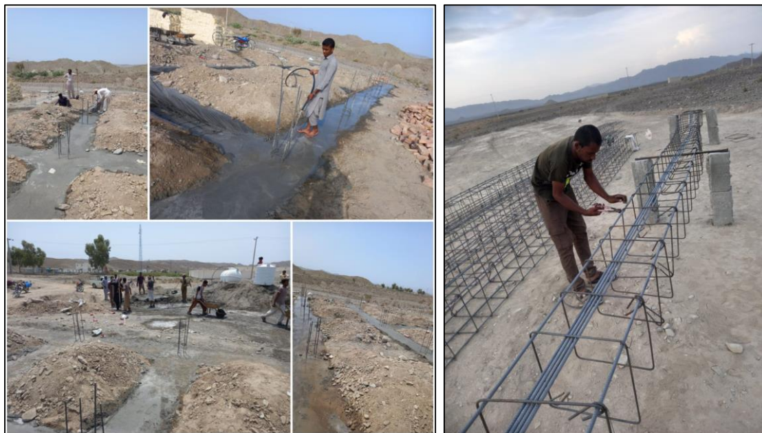
تصاویر شماره چهار: آرماتوربندی و بتون‌ریزی مشارکتی مدرسه با همراهی اهالی توتان
