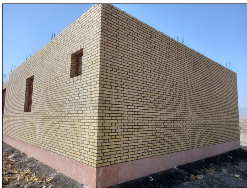
تصویر شماره شش: پایان آجرچینی دیوار خارجی ساختمان مدرسه
