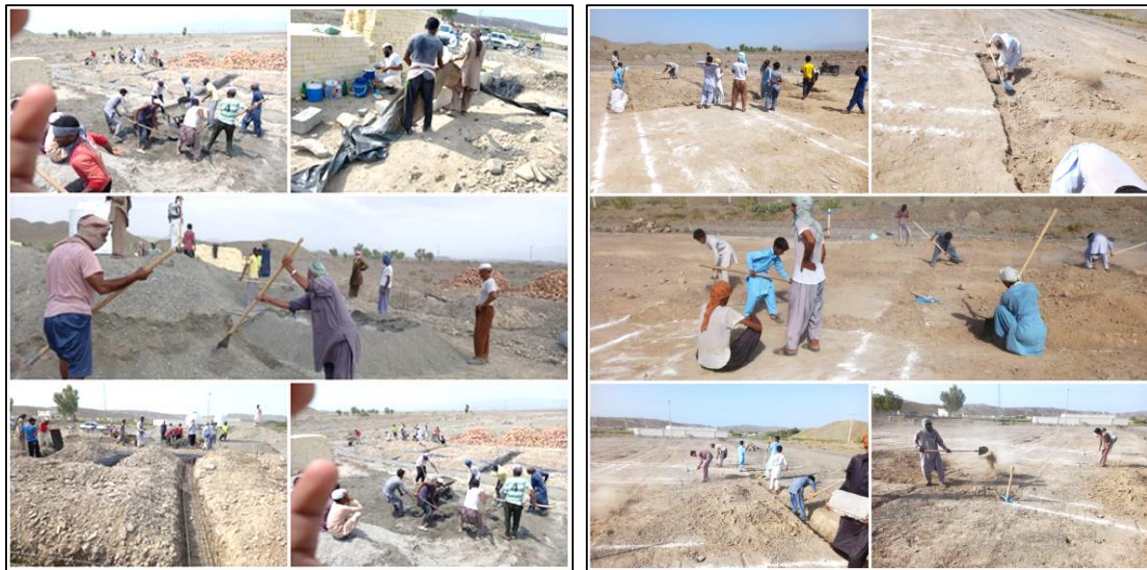
تصاویر شماره سه: پی‌کنی و اجرای فنداسیون مدرسه با همکاری داوطلبانه اهالی روستاهای دهستان توتان
